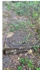
Foto 10 - Tampa de inspeção
