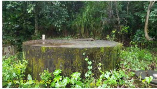
Foto 4 - Filtro anaeróbio
