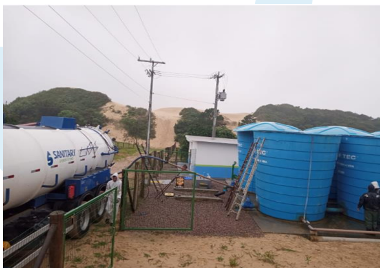
Figura 6 - Limpeza dos Reservatórios do SAA Campo Bom (em 10/10/2024).
