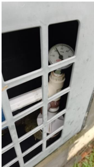
Figura 7 - Manômetro instalado em um cavalete de água para realização do monitoramento da pressão na rede de abastecimento.
