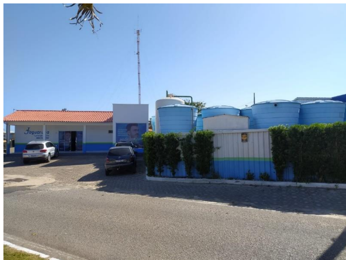
Figura 3 - Estação de Tratamento de Água Arroio Corrente. Fonte: Jaguaruna Saneamento.
