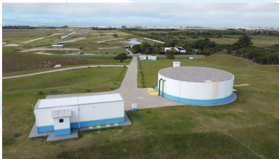
Figura 2 - Estação de Tratamento de Água Parque dos Butiás. Fonte: Jaguaruna Saneamento.
