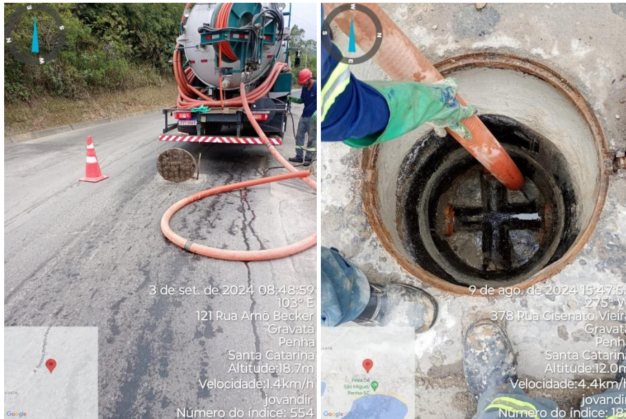
Figura 30 – Limpeza preventiva de rede.
