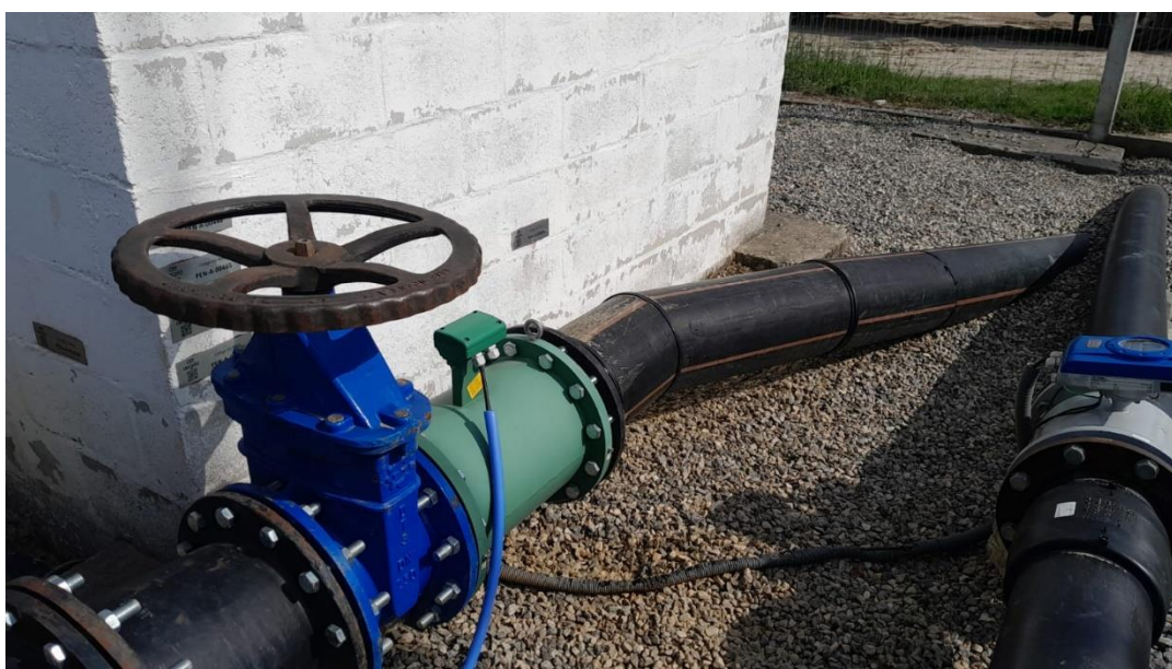
Figura 10: Nova captação DN250mm Lagoa 2.
