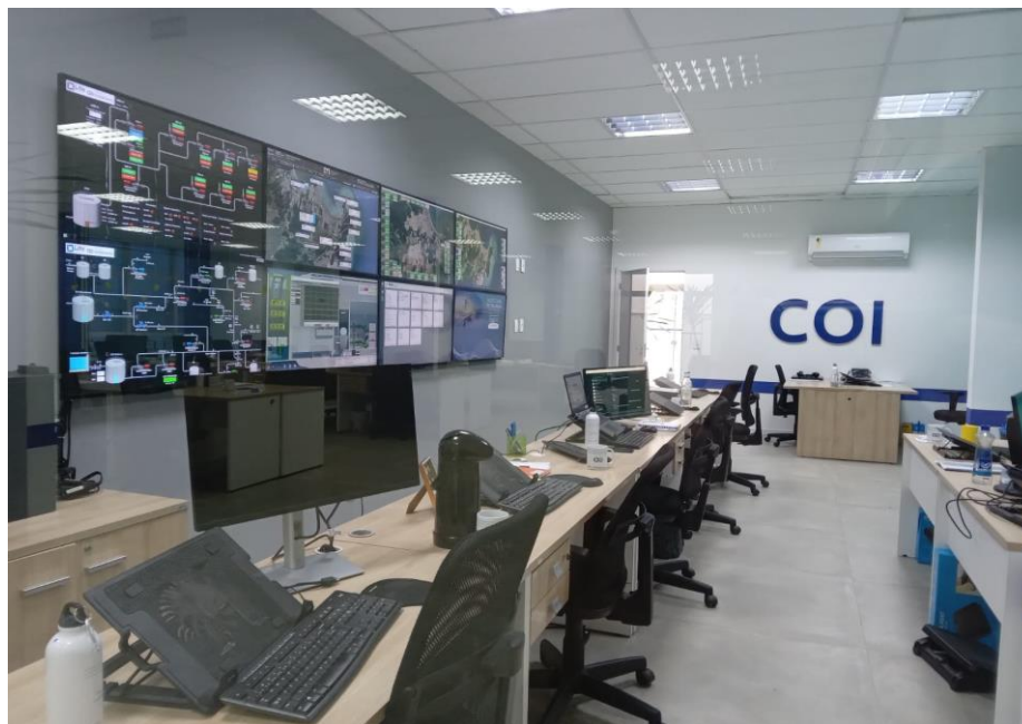
Figura 09: Sala de Centro de Controle Operacional
