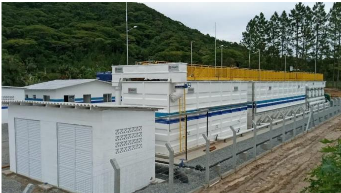
Figura 04: ETA Penha, 87L/s, bairro Santa Lúcia.
