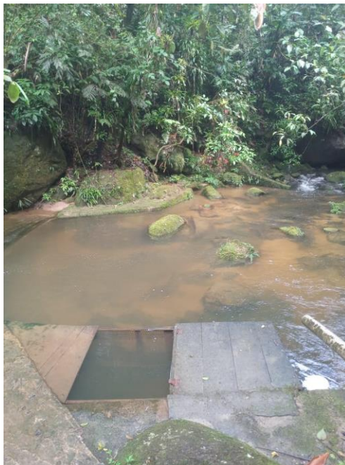
Figura 11: Captação Córrego Alegre
