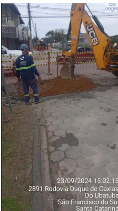
Figura 19: Interligação de rede de água
