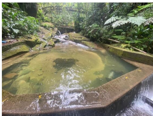
Figura 09: Captação Córrego Rita
