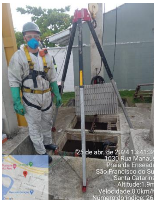
Figura 32: Limpeza Preventiva na Elevatória J
