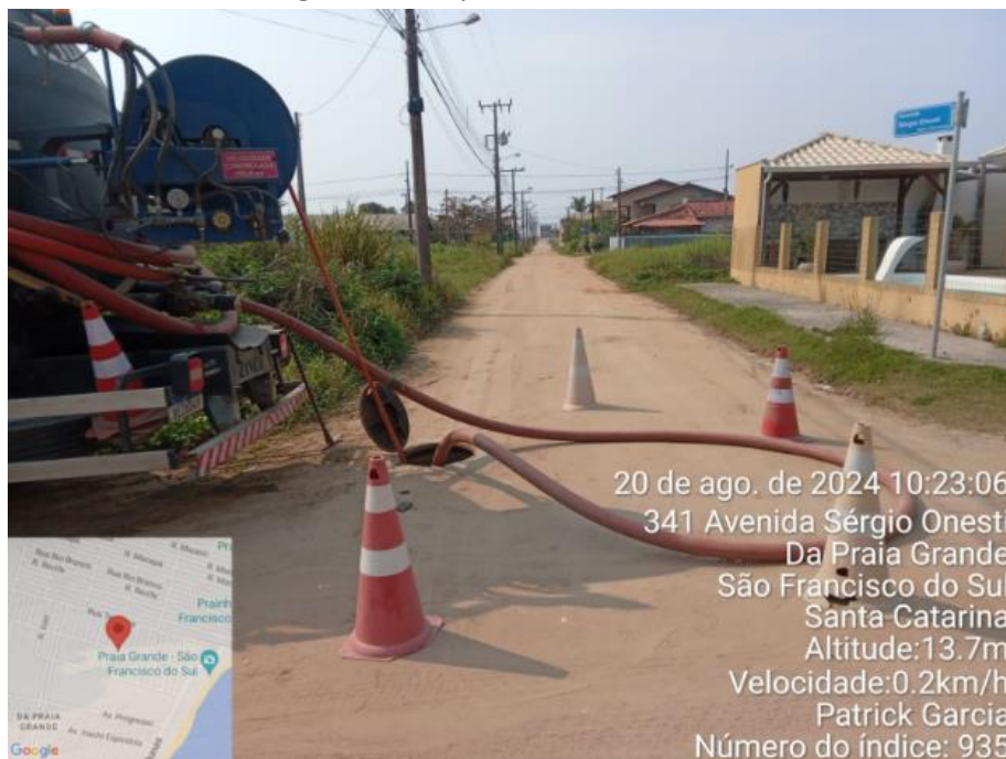
Figura 34: Limpeza preventiva na RCE
