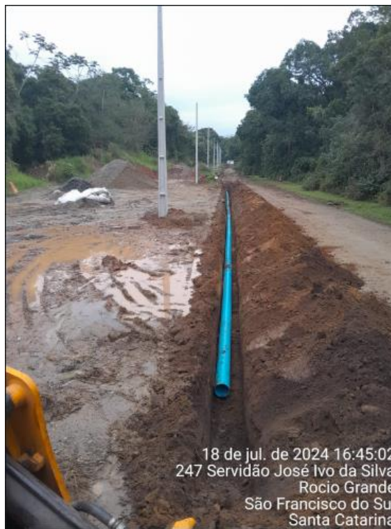
Figura 15: Substituição de rede na Captação do Laranjeiras
