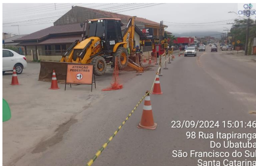
Figura 18: Melhoria do abastecimento de água no Jardim Geovana II
