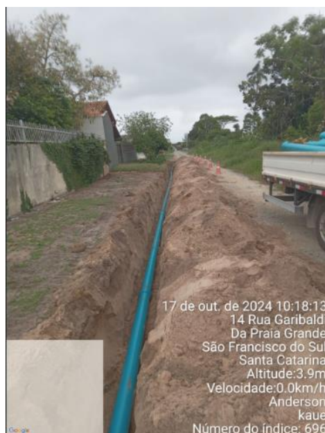
Figura 20: Interligação de rede de água na Praia Grande
