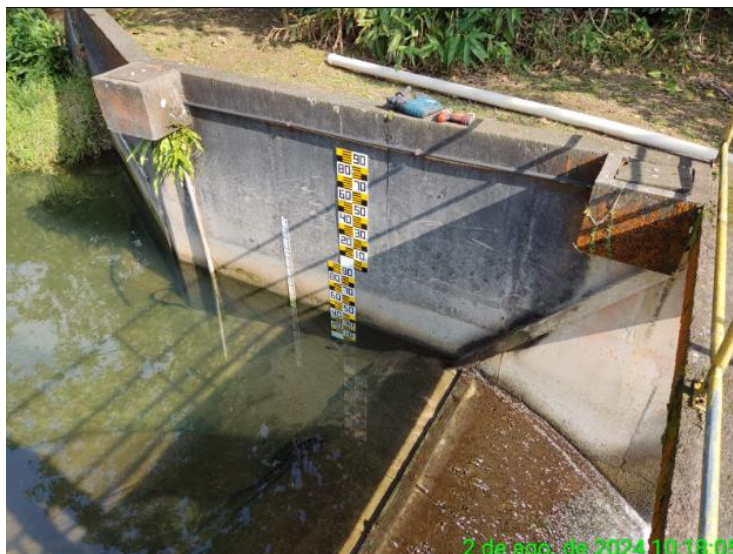
Figura 16: Régua na Captação do Sai-Mirim
