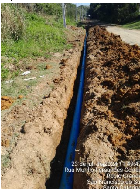
Figura 14: Substituição de rede na Captação do Laranjeiras
