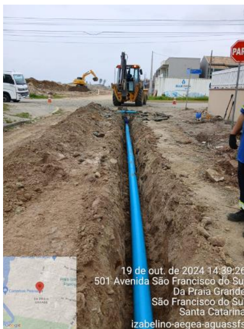
Figura 21: Interligação de rede de água na Praia Grande
