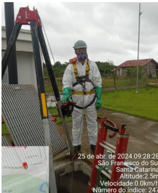
Figura 31: Limpeza Preventiva na Elevatória Interna da ETE Ubatuba
