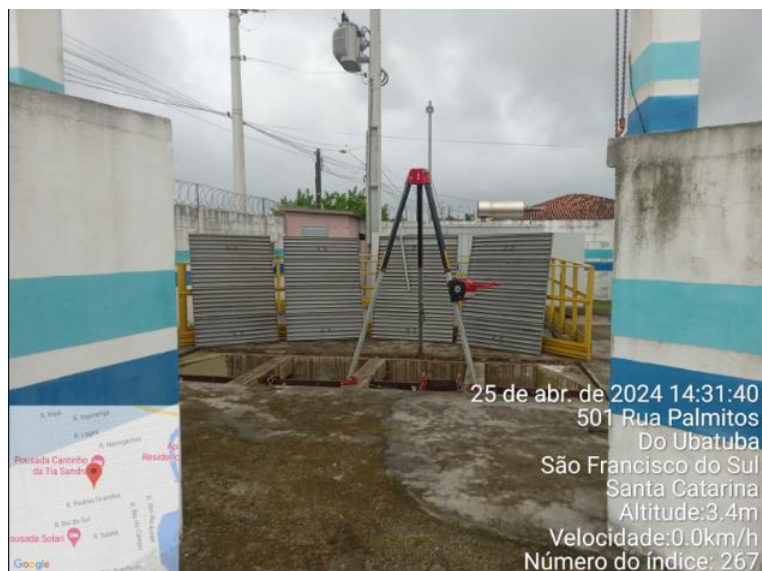
Figura 33: Limpeza Preventiva na Elevatória A
