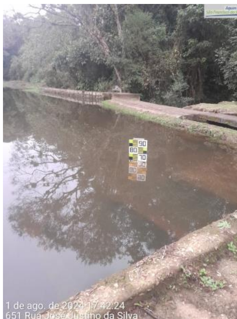
Figura 17: Régua na Captação do Sai-Mirim
