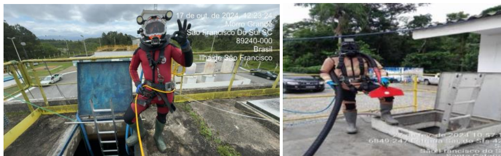
Figuras 24 e 25: Limpezas preventivas de reservatórios
