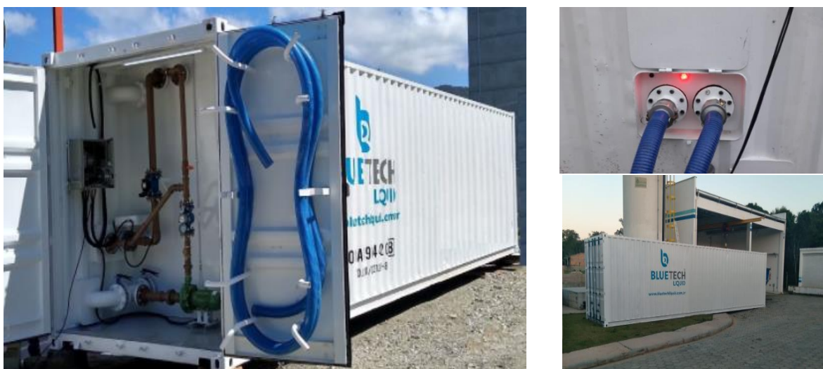
Figuras 26 e 27: Implantação do booster-contêiner em SFS
