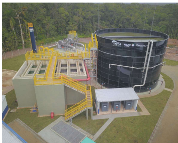
Figura 16 – Estação de tratamento de Esgoto Finalizada
