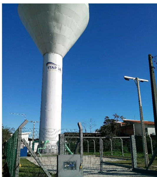
Figura 8 - Reservatório Itapema do Norte.
