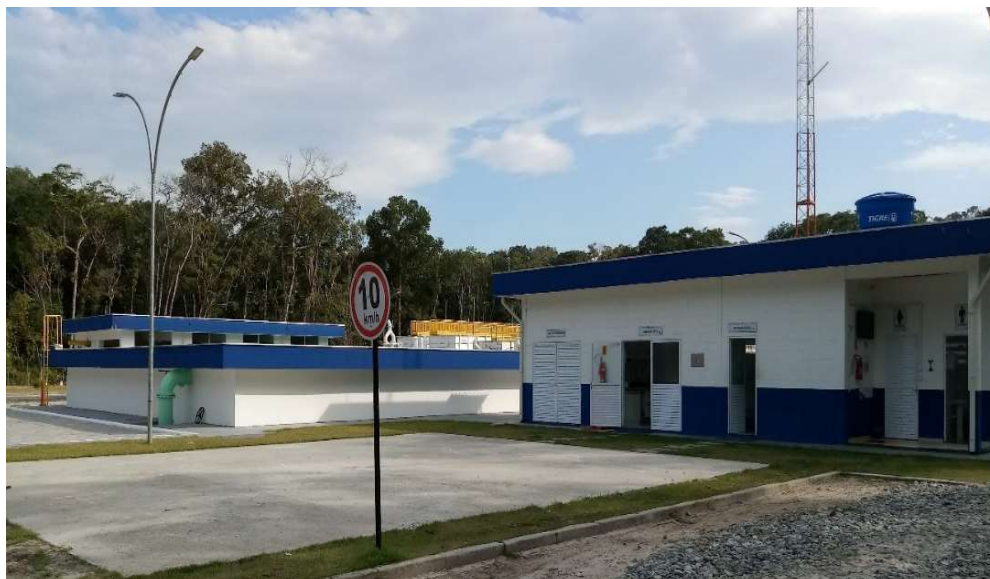
Figura 9 - Reservatório ETA Maria Catarinense.
